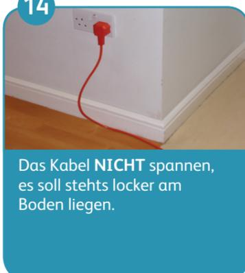
Das Kabel **NICHT** spannen, es soll stets locker am Boden liegen.
